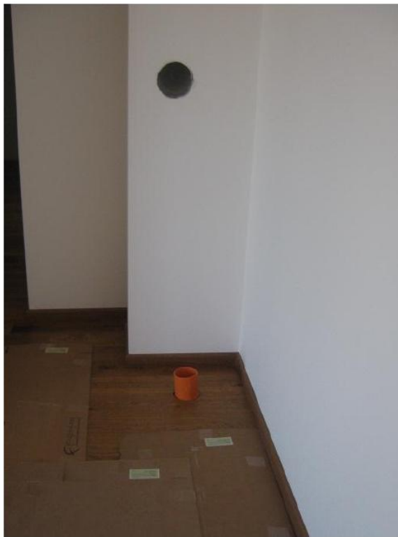
Predisposizione ingresso aria a pavimento
