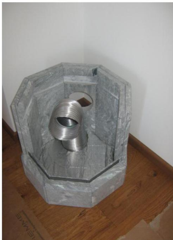
Tubazione di raccordo
